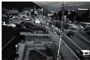
調査区全景・十郎橋西交差点（西から）
