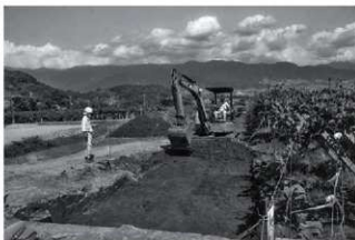
③区下段 表土掘削 西から
