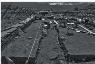
②区 作業風景 西から
