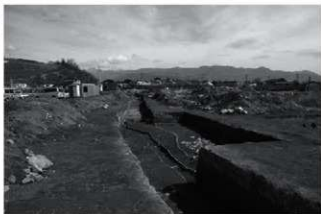
TR11 SD27・31 完掘 西から
