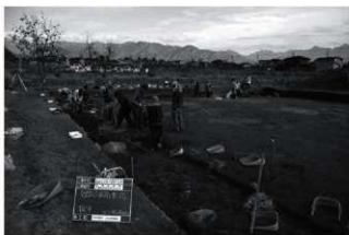
包含層掘削状況
