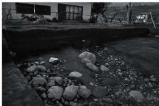
TR8 SD13-14 西壁 南東から
