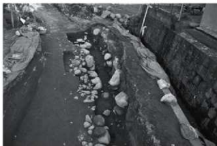
3区 水路検出状況 (西から)
