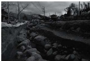
4区 水路検出状況 (西から)
