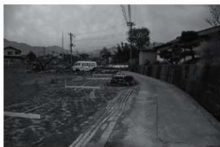
調査前（西から）
