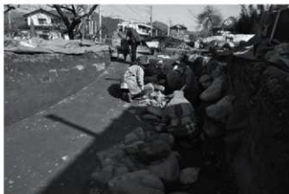
3区 作業風景 (西から)
