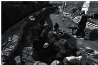
3区 作業風景 (東から)
