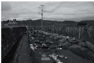
3区 作業風景 (東から)
