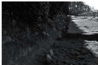
5-2区 SD3・S12 北から
