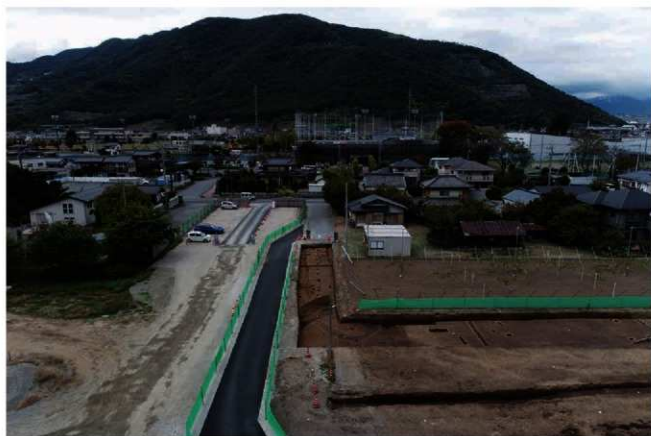
調査区北西部 南から
