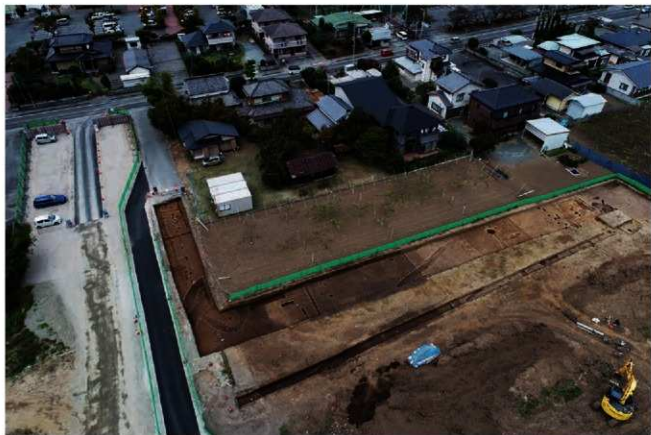
調査区中央部・北西部 南西から
