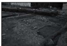
A 地点 SS6 ~ SS8(南東から)
