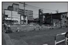
①区着手前状況 (北西から)
