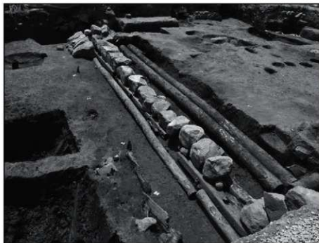
⑥区 SS1 胴木敷設状況(北から)
