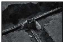
相生工区継手接続状況 (北から)
