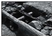
①区 SS1 胴木敷設状況(南から)
