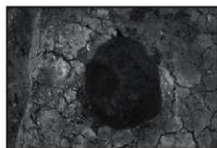
⑤区 SP23(南から)
