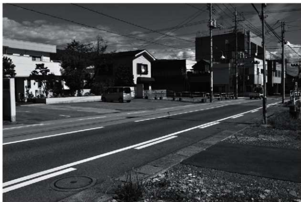
⑧区着手前状況(南西から)
