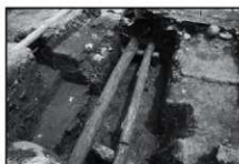
⑧A区 SS1 胴木敷設状況(南から)
