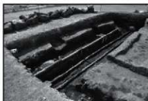
⑤区 SS1・SS2 胴木敷設状況(西から)
