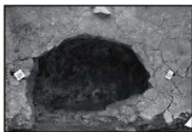
④区 SK7(西から)
