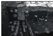
相生工区 SS1E トレンチ (東から)
