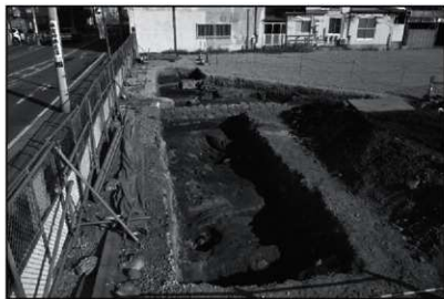
D地点全景写真(南から)
