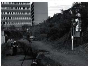
42. 実測作業風景 (南から)
