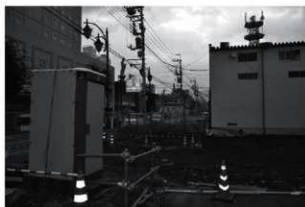
調査前現況（南から）
