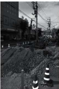
調査後状況（南から）
