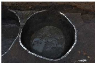
SK2 掘方完掘状況 南から
