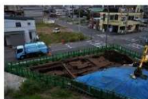
A地点西側 完掘状況 東から
