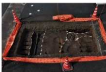
H地点 完掘状況 東から
