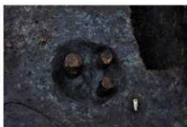
A地点 SS2B 木杭検出状況 北から
