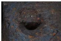
B-1 地点 SP65 セクション 南から
