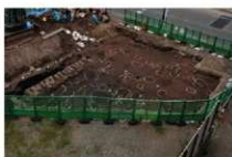
A地点東側 検出状況 東から
