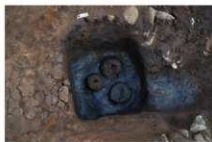
④・⑤地点 SS16 木杭検出状況 南から
