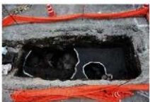
B地点東部部 完掘状況 西から
