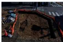
L地点 完掘状況 西から
