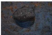
E地点 SP89 セクション 南から
