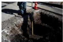
I地点 深掘り確認状況 西から
