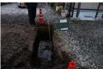
C-3 地点西トレンチ 重機掘削状況 南から
