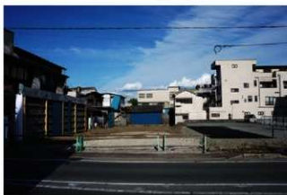
着手前の調査地点全景 西より
