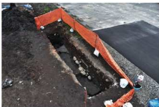
第2遺構面完掘状況 北西より
