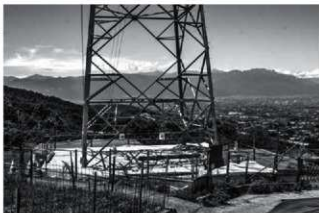
調査区近景 (調査後) 東から
