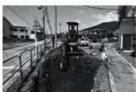
163.①区表土掘削状況
