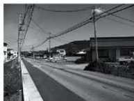
160.②区調査前状況 (南から)
