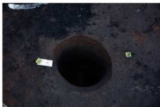
SP1(S11内)完掘 南から
