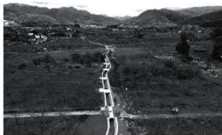
道跡遠景 完掘状況 南から
