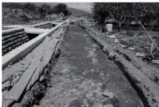
1号溝 検出状況 南から
