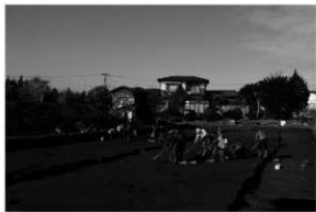
Ⅲ区 作業風景
