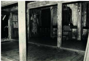
写真3 西明寺観音堂内部
