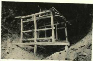
3の1 岩屋洞外観
