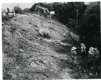
ユンボによる表土剥ぎと遺構確認
