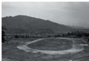
造成工事が終わったグランドと霊山の山並み
