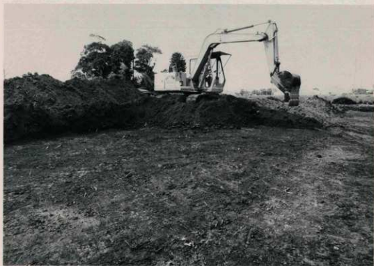
重機作業風景
