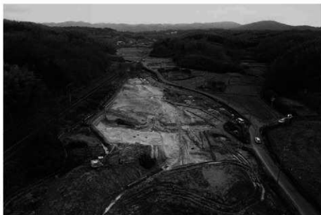
(1) 鹿背山瓦窯跡第 2 次調査地遠景 (北西から)
