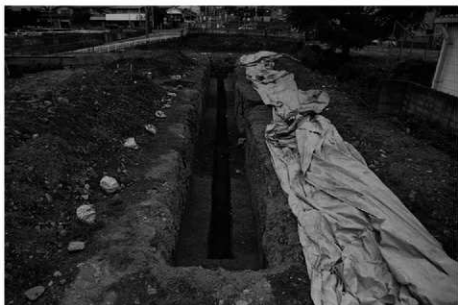
(2) 調子地区 ＜長岡京跡右京第 902 次＞ 1 トレンチ全景（東から）
