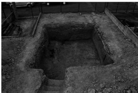
(3) 荒堀地区 ＜長岡京跡右京第 902 次＞ 4 トレンチ全景（西から）
