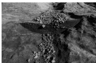
(3) S F 27 D-D' 地点上下路面石敷き断面 (北西から)
