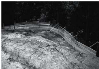
第3図 土留め柵設置状況
