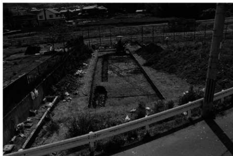
(1) 尾流地区 <長岡京跡右京第 902 次> 1 トレンチ全景 (北から)
