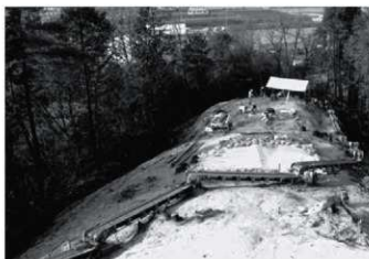
第4図 ベルトコンベヤー設置状況
