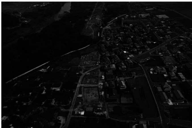
(2) 調査地遠景 (空撮・西から)
