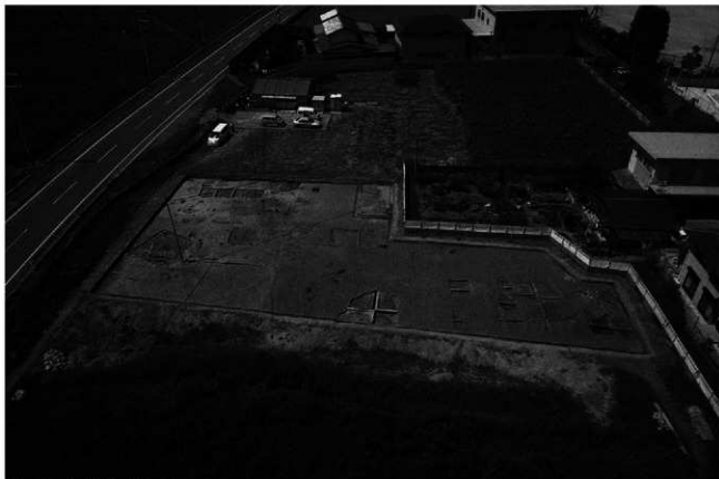
(1) 1区調査地全景（東から）
