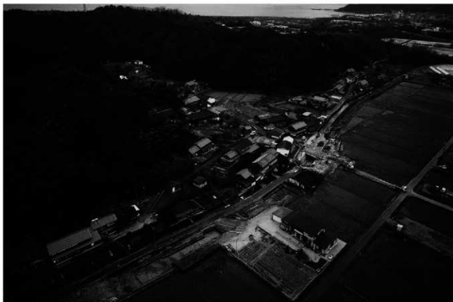
(1) 調査地遠景 (南上空から)
