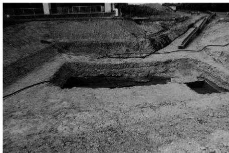
(3) 調査地全景 (南から)
