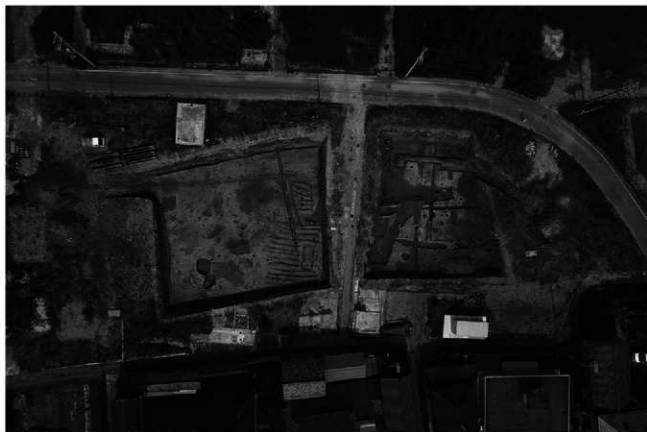
(2) B・C地区全景 (空撮・上が北)
