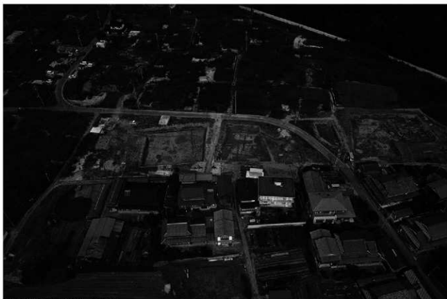
(2) 調査地全景 (空撮・南から)
