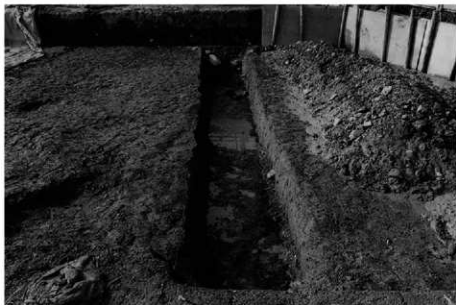
(1) 1 トレンチ東端部 サブトレンチ(南から)
