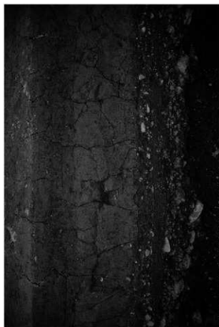
(2) 1区南濠土層断面(部分)(北から)
