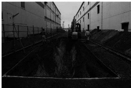
(3) 第1トレンチ重機掘削 作業風景(東から)
