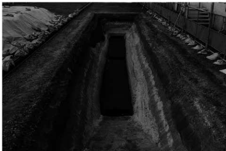
(1) 第1トレンチ全景(西から)
