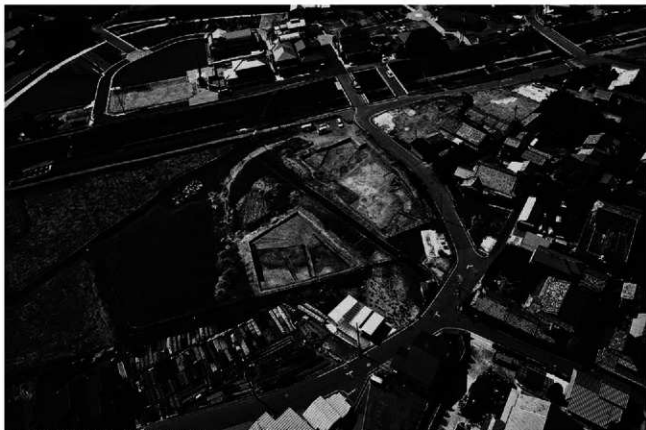
(1) 上内田地区遠景 (北東上空から)
