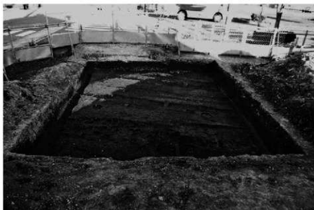
(2) 第 1 トレンチ全景(西から)
