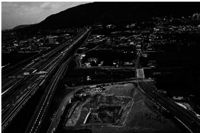
(1)調査地全景(北東から)
