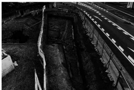
(2) 調査地全景(南西から)
