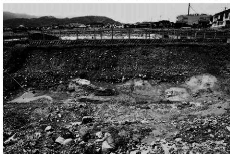
(2) 樽井地区北壁断面(南から)
