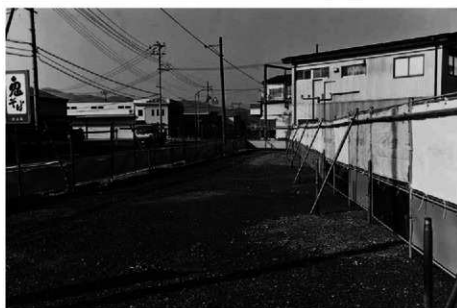
(3) 掘削前の状況(北から)
