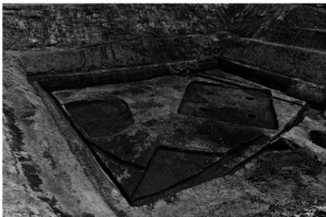
(2) トレンチ全景(南西から)
