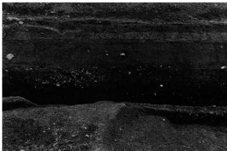
(3) トレンチ西壁断面(東から)
