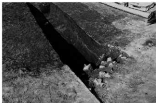
(7) 断ち割り 15 (南西から)
