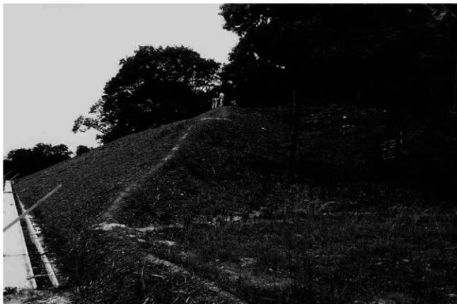
(1) C地区調査前全景(南東から)
