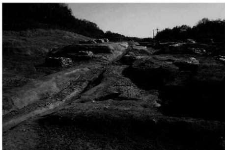
(2) 埋め戻し作業状況(北から)
