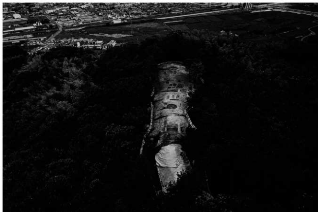
(1) B1地区全景(南東から)
