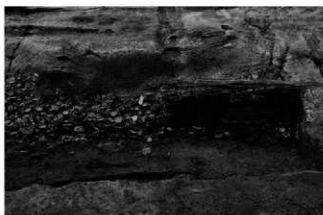
(7)川跡S R01の5区護岸施設(南から)
