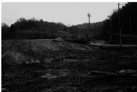
(3) 埋め戻し作業状況(北西から)
