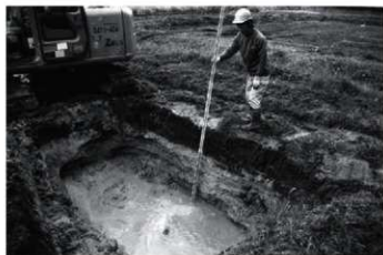
第6図 B-1地区掘削状況(南西から)
