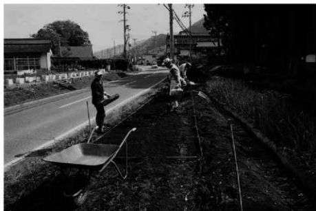
(1) 2区作業風景(南西から)
