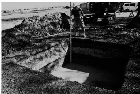
(2) G地区掘削状況(北西から)
