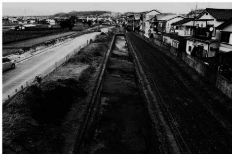
(1) 調査トレンチ全景(南から)
