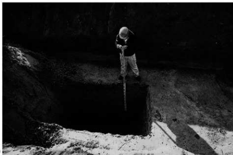
(2) D地区重機深掘り状況(北から)
