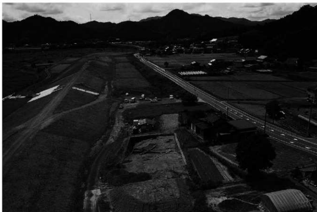
(1) 調査地の状況(北東から)
