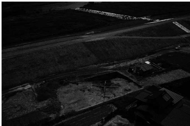
(3) 第3次1区下層調査状況(北西から)
