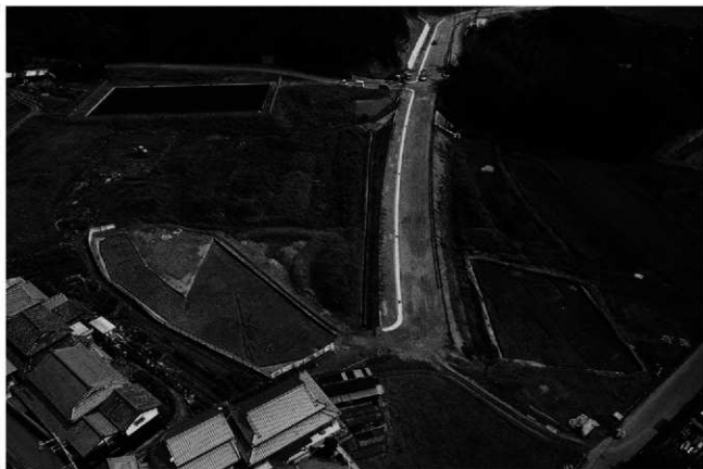
(2) 1・2区近景(西から)
