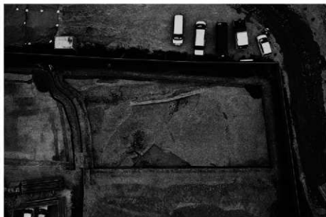
(1) c2-2地区全景(上が北東)
