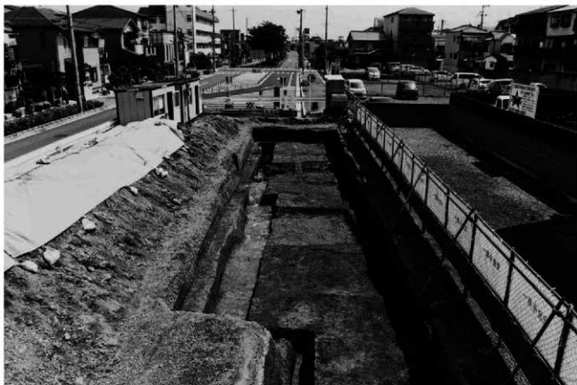
(1)調査区全景<上層> (北から)
