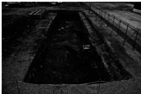
(3) 2トレンチ全景(北東から)
