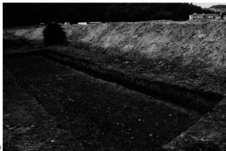
(1)西代地区1トレンチ(北東から)
