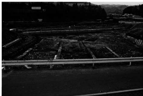
(3) 尾流地区下層遺構全景 (北東から)
