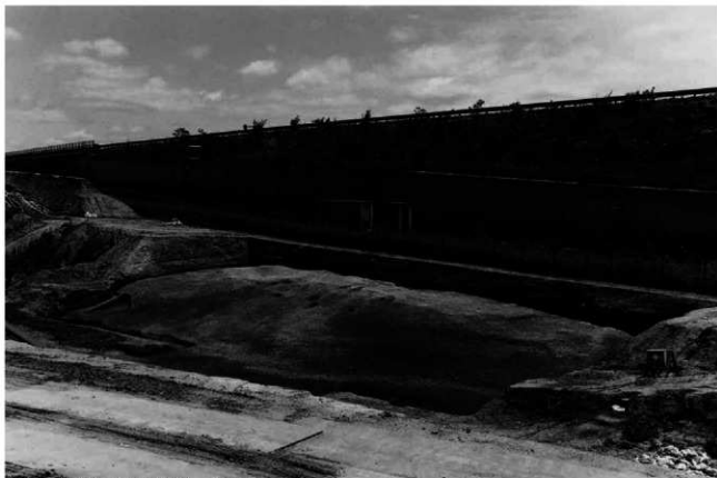
(1) 第12次調査全景(表土掘削後：南西から)
