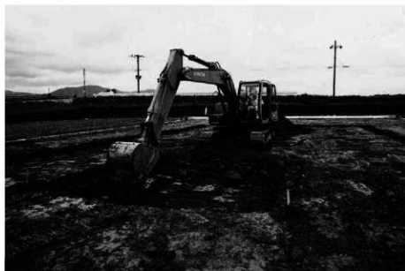
(1) 7トレンチ重機掘削(北から)
