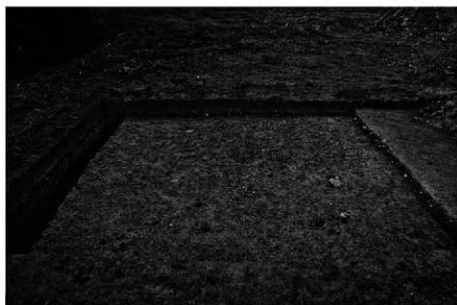
(2)西代地区8トレンチ(東から)
