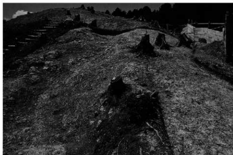
(2) A地区曲輪北東斜面掘削状況 (北東から)
