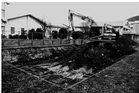
(2) Bトレンチ重機掘削(南東から)
