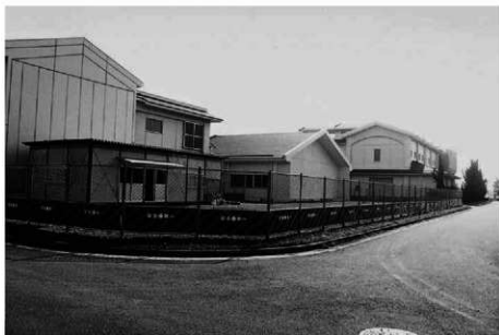
(1) Bトレンチ調査前(北西から)
