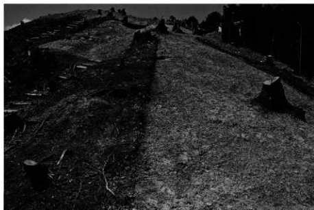
(1) A地区曲輪北東斜面掘削状況 (北東から)
