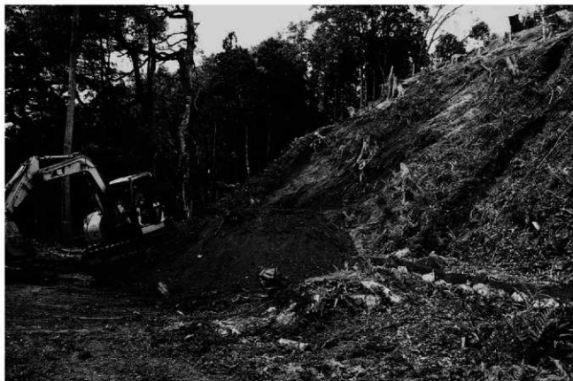
(1) 切岸2掘削状況(南から)
