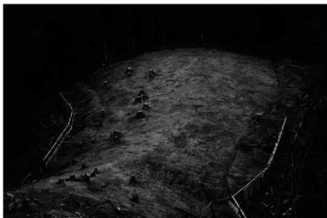
(2) C地区掘削状況(南西から)
