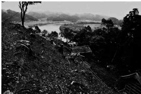
(2) 第4・8トレンチ調査前 (北から)
