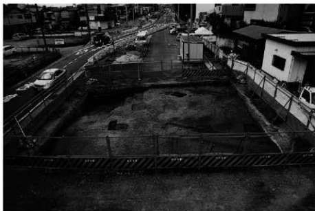
(3) 2 トレンチ南半部全景(北から)
