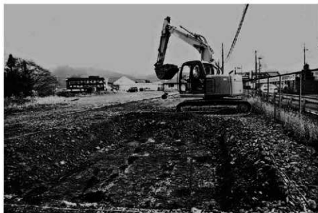
(2) 第 1 トレンチ重機掘削状況 (西から)
