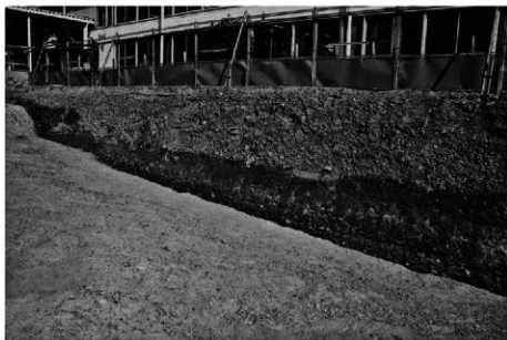
(3) 南東部南壁断面(北西から)
