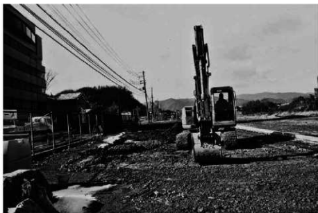
(3) 調査終了後、重機による埋め戻し作業状況
