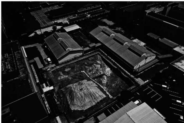
(1)調査地全景(空撮写真：西北西から)
