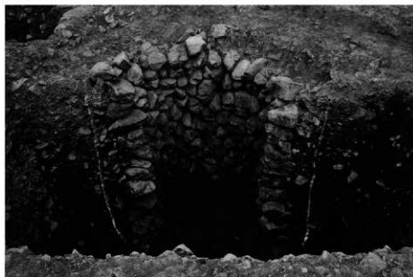
(1) 井戸 S E 10 断ち割り状況 (西から)
