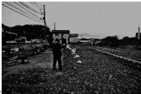
(3) 第1トレンチ測量状況(東から)
