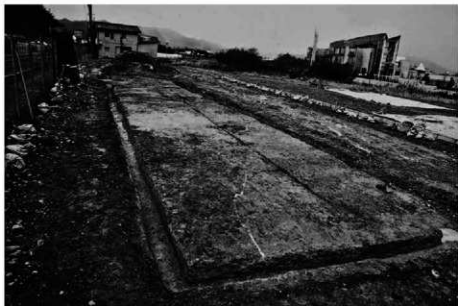
(1) 第2トレンチ完掘状況 (南東から)
