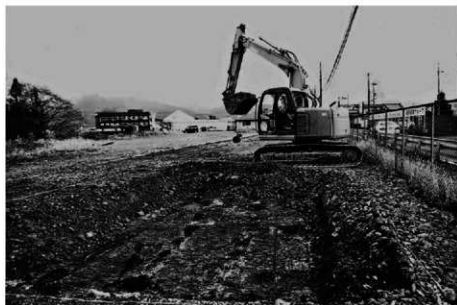
(2) 第1トレンチ重機掘削状況 (西から)
