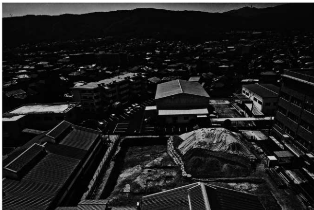
(2) 調査地全景(空撮写真：東から)
