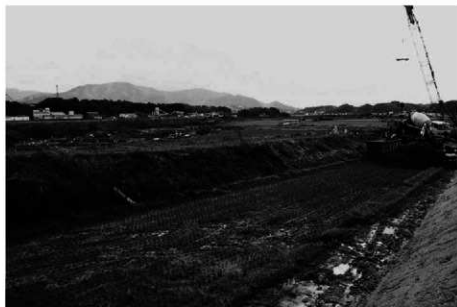
(1) 調査前、鳥取橋西詰より 南を望む(北から)
