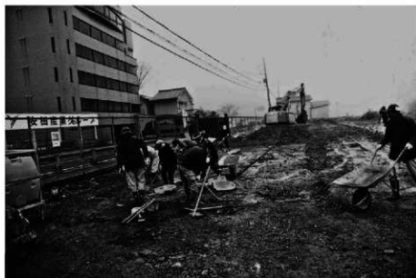
(1) 第2トレンチ荒掘り状況 (東から)
