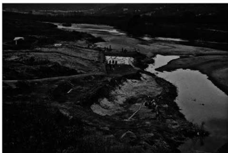
(3) 第21次調査地全景(東から)
