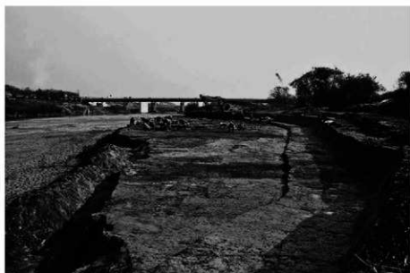
(2) 第20次調査地上層掘削状況 (西から)
