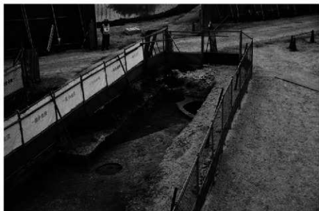
(2) 調子a4-1地区溝 S D554 (東から)
