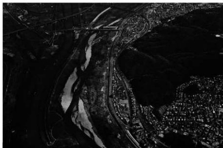
(2) 第20次調査地全景(西から)
