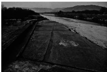
(3) 第20次調査地上層全景(東から)
