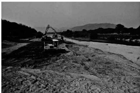
(2) 第20次調査地重機掘削状況 (東から)
