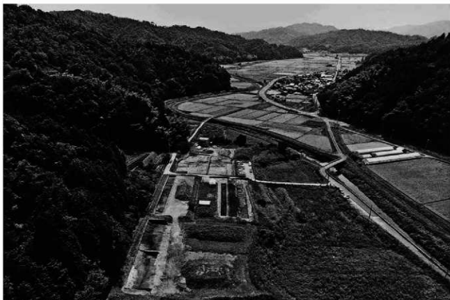
(1) A・B地区全景(北東から)
