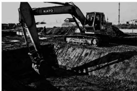
(2) 第6トレンチ重機掘削作業 (北東から)
