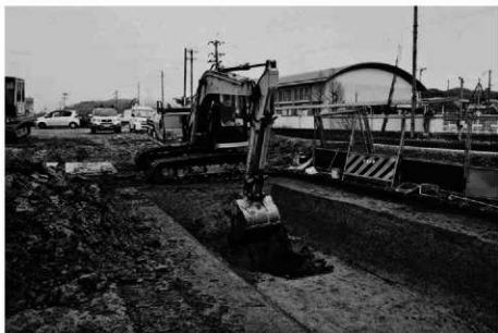
(1) 第8トレンチ断ち割り作業 (南西から)
