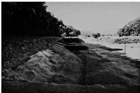
(2) D地区全景(北東から)
