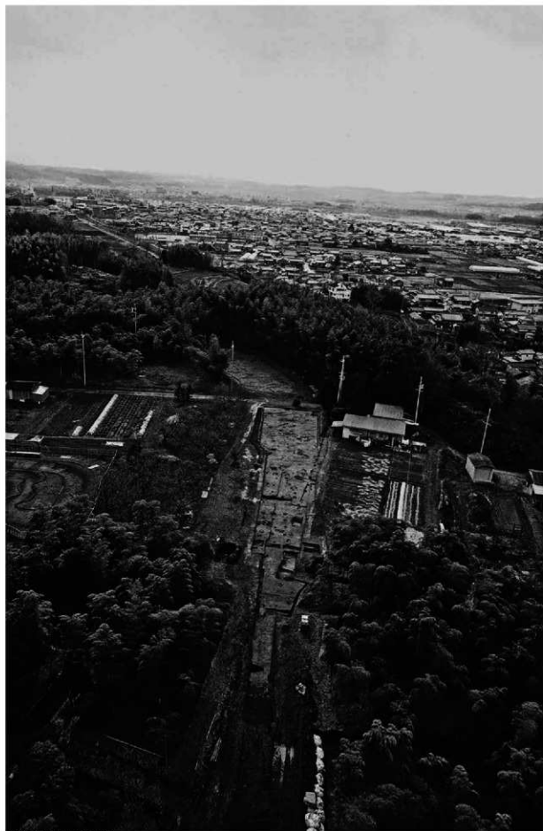
調査地近景(北東から)
