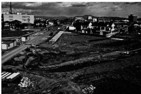
(3) 4 トレンチ(南西から)
