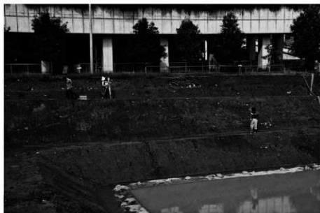
(2) 調査地内への基準点 設置作業状況(東から)
