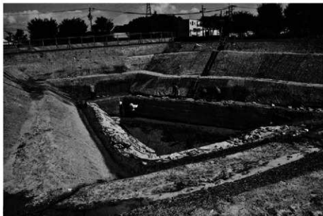
(1) 掘削作業状況(北東から)
