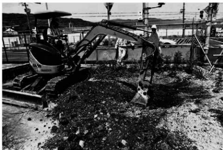
(1) d 2 地区重機掘削状況 (南東から)
