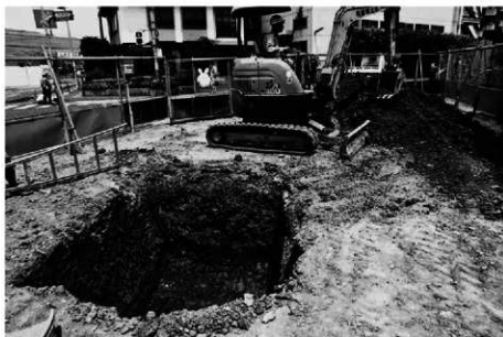
(1) d 3 地区重機掘削状況 (南東から)
