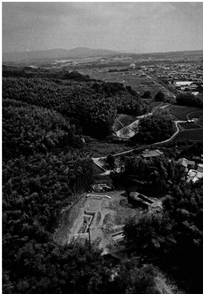
調査地遠景(北から)
