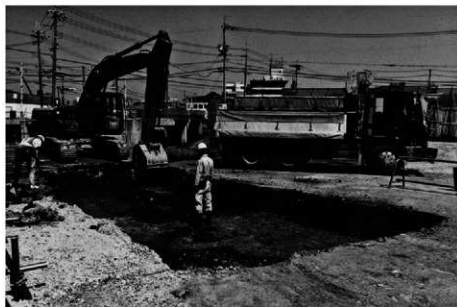
(1) d 1 地区重機掘削状況 (南から)
