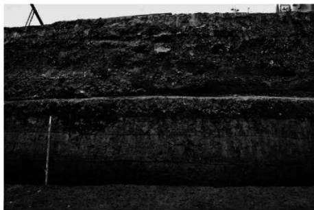
(3) 1 トレンチ東壁断面(西から)
