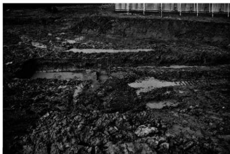
(3) b 7 地区全景(東から)
