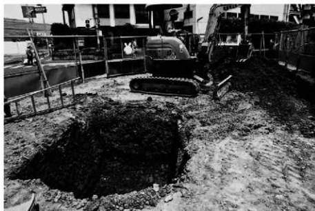
(1) d 3 地区重機掘削状況 (南東から)
