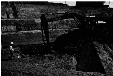
(2) 重機による深部掘削状況 (西から)
