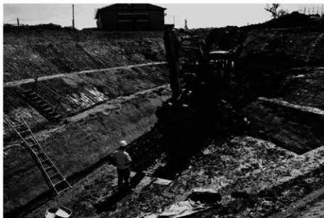
(1) 重機による深部掘削状況 (北西から)
