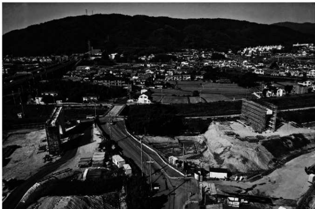
(1) 空中撮影写真(東から)
