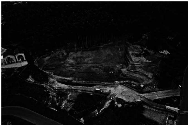
(1)高山Aトレンチ全景(南東から)
