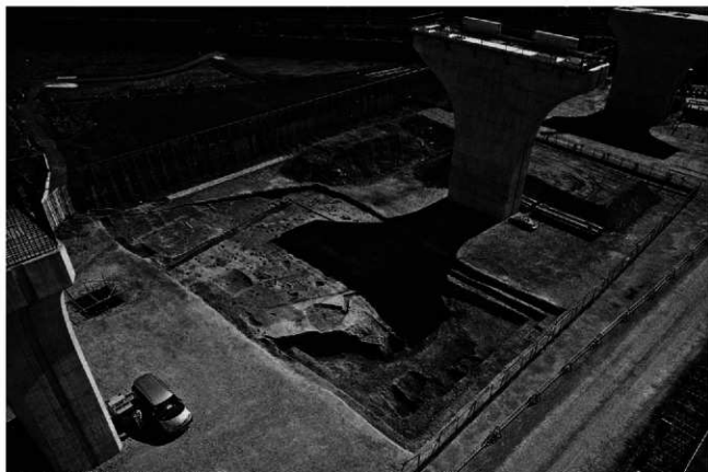
(1) b 8 - 3 地区全景(北西から)
