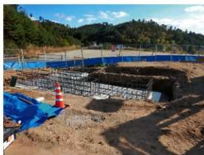
トイレ基礎工事
