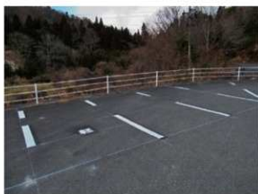
駐車線区画線完成 2
