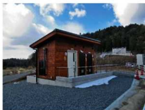
トイレ完成（前面）
