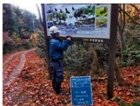
サイン取付工事 1
