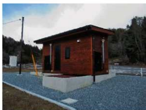
トイレ完成（背面）
