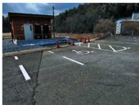
駐車線区画線完成 1
