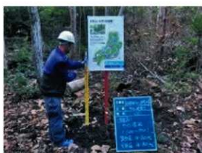
サイン取付工事 4
