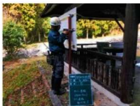
サイン取付工事 3
