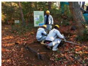
丸太階段工事 2
