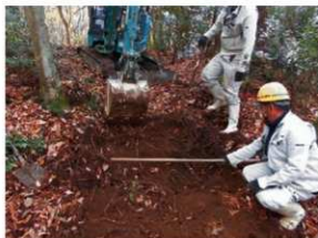
丸太階段工事 1
