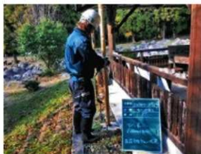
サイン取付工事 2
