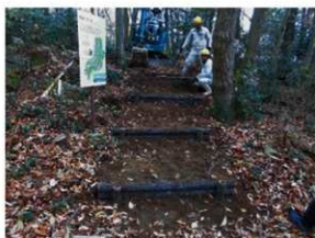
丸太階段工事 3
