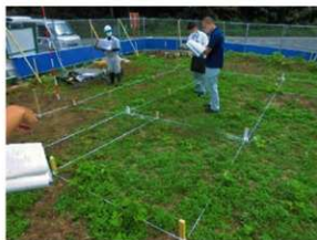
トイレ工事箇所確認
