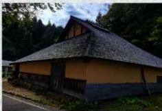
菅谷たたらの高殿 (近世たたら製鉄の建物や作業場がそのまま残る)
