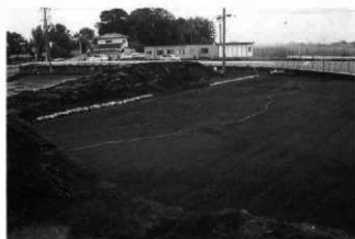
6. A区 As-B下旧地表面 全景 (北西→)
