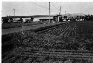
現在の水田と道路の段差
