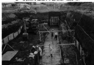
CKD区境現道下掘削工事作業風景 (谷)
