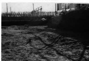
西微高地部段差
