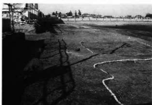
西微高地部段差
