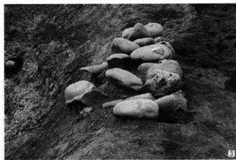
B区まんがら池への分水部
